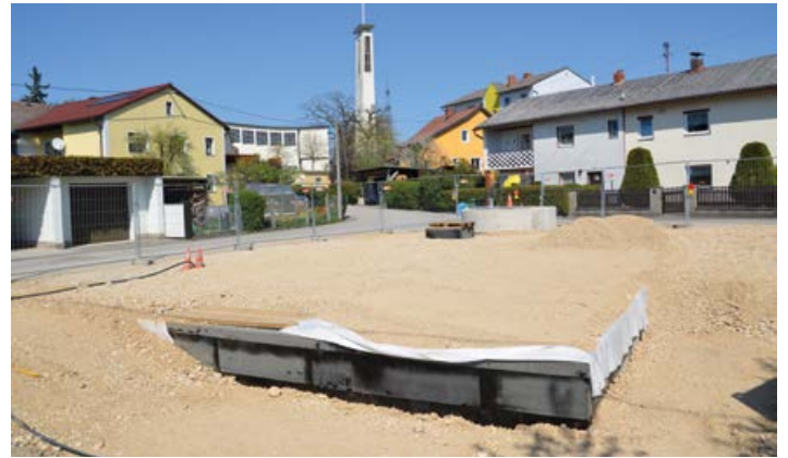
Am Gangsteig in Doppl-Hart wird ein neues Pumpwerk gebaut.
