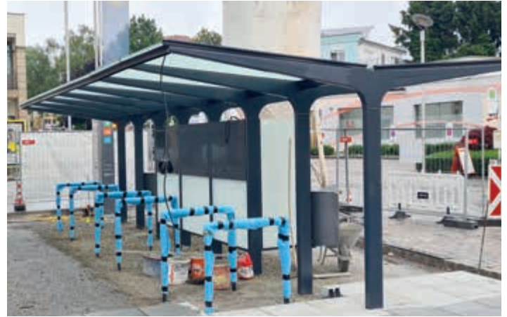
Ende Juni starteten die Arbeiten für die neue Bushaltestelle.
