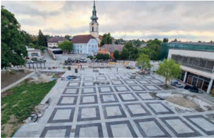
Die Umbauarbeiten gingen zügig voran.
